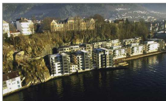
GEORGERNES VERFT 1: GENERAL VIEW
